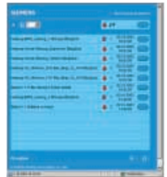
Die übersichtliche Alarmliste zeigt die aufgetretenen Störungen in klar verständlicher Form.
